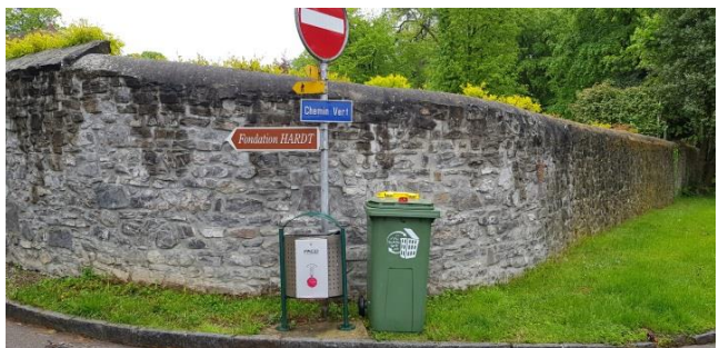
Angle Ch. Vert - Ch. de la Planta
