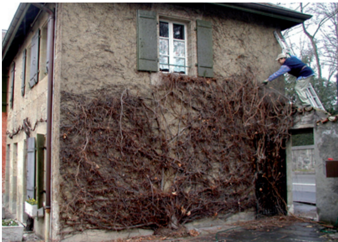
En vue des travaux de réfection des façades, Fernando Coelho enlève la vigne
