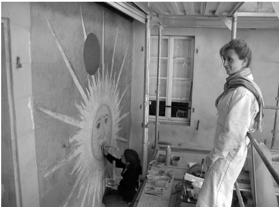
Restauration du Soleil de la façade de l'annexe de la mairie
